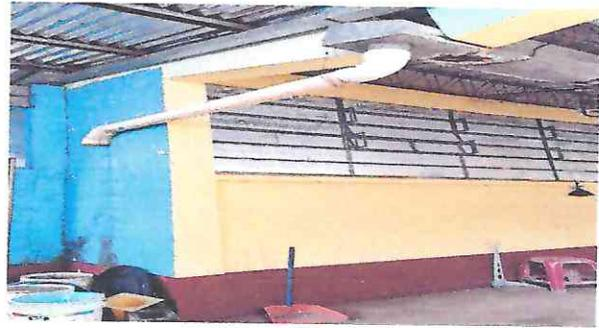
Foto 4: sustitución bajada de agua pluvial tubo pvc 3 pulgadas
