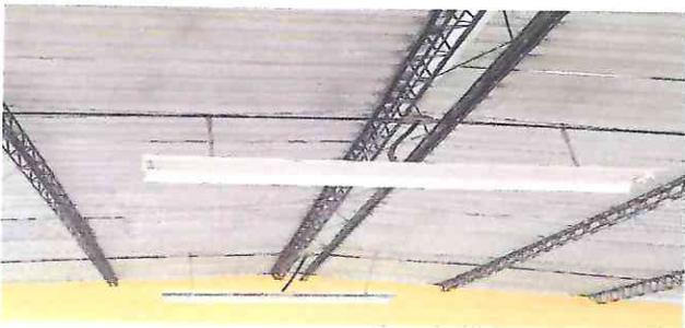
Foto 5: sustitución de lamina por lamina troquelada
